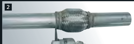
2 An der gekennzeichneten Stelle (hinter der Schweißnaht) altes Flexrohr mit der Flex abtrennen.
